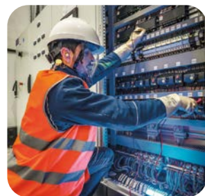
Mise en conformité d'installation frigorifique dans le cadre de la réglementation F-Gaz par Equans
