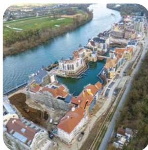
Conversion d'une ancienne usine Lafarge en un quartier avec marina : Seine Parisii (Bouygues Immobilier)
