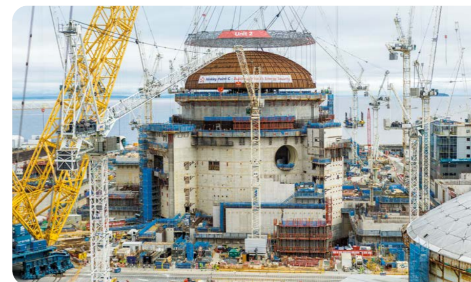
ROYAUME-UNI - EPR d'Hinkley Point C, réalisé par la JV BYLOR (Bouygues Travaux Publics, Laing O'Rourke). L'exploitation de l'EPR d'Hinkley Point C contribuera à éviter l'émission de ~9 MT de CO 2 /an, soit deux fois les émissions annuelles de Bouygues Construction.
