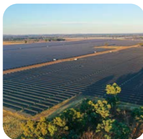
Ferme solaire de Culcain en Australie, s'étendant sur plus de 1000 hectares (Bouygues Construction et Equans)
