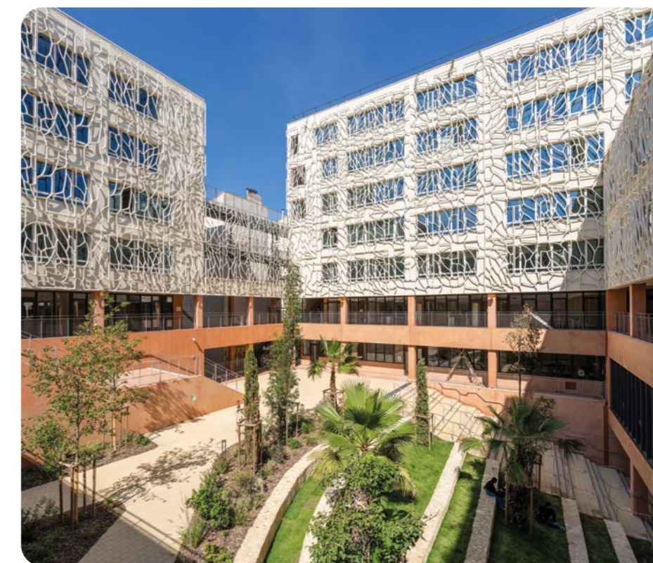
FRANCE - À Marseille, Bouygues Construction a construit la Cité scolaire internationale Jacques Chirac tandis qu'Equans en assurera l'exploitation.
