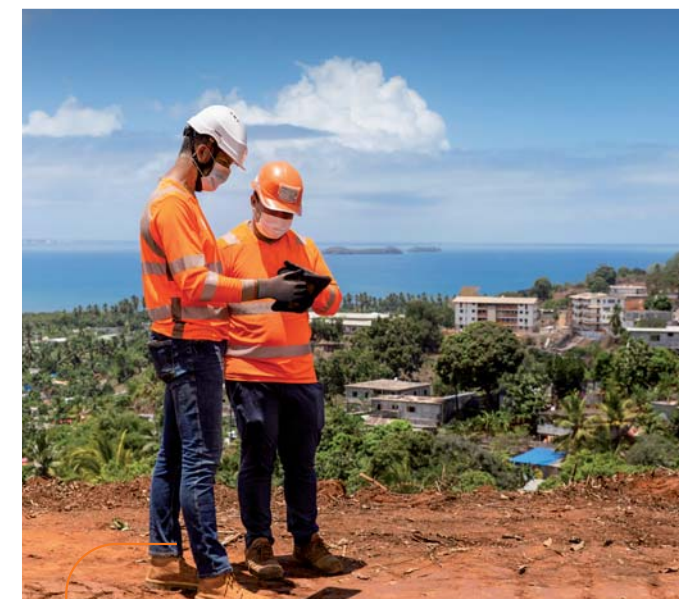
Sur les hauteurs de Mayotte, Colas participe à la construction du futur technopôle de Dombéni.
