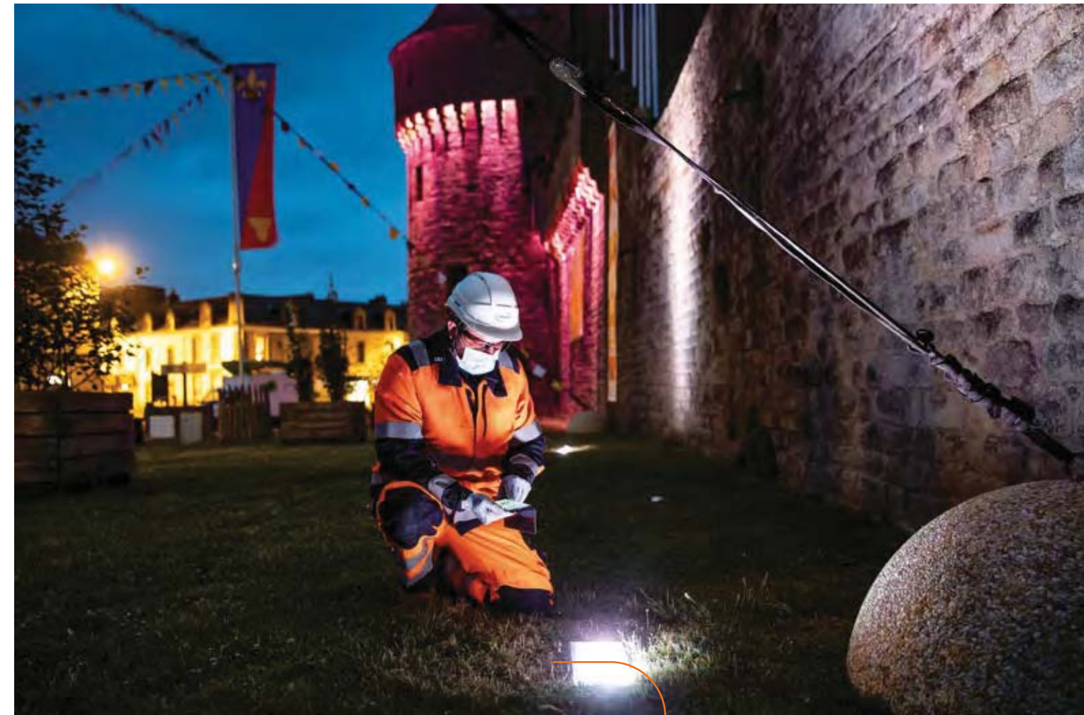
Opération de maintenance de l'éclairage public de la cité médiévale de Guérande, en Loire-Atlantique
