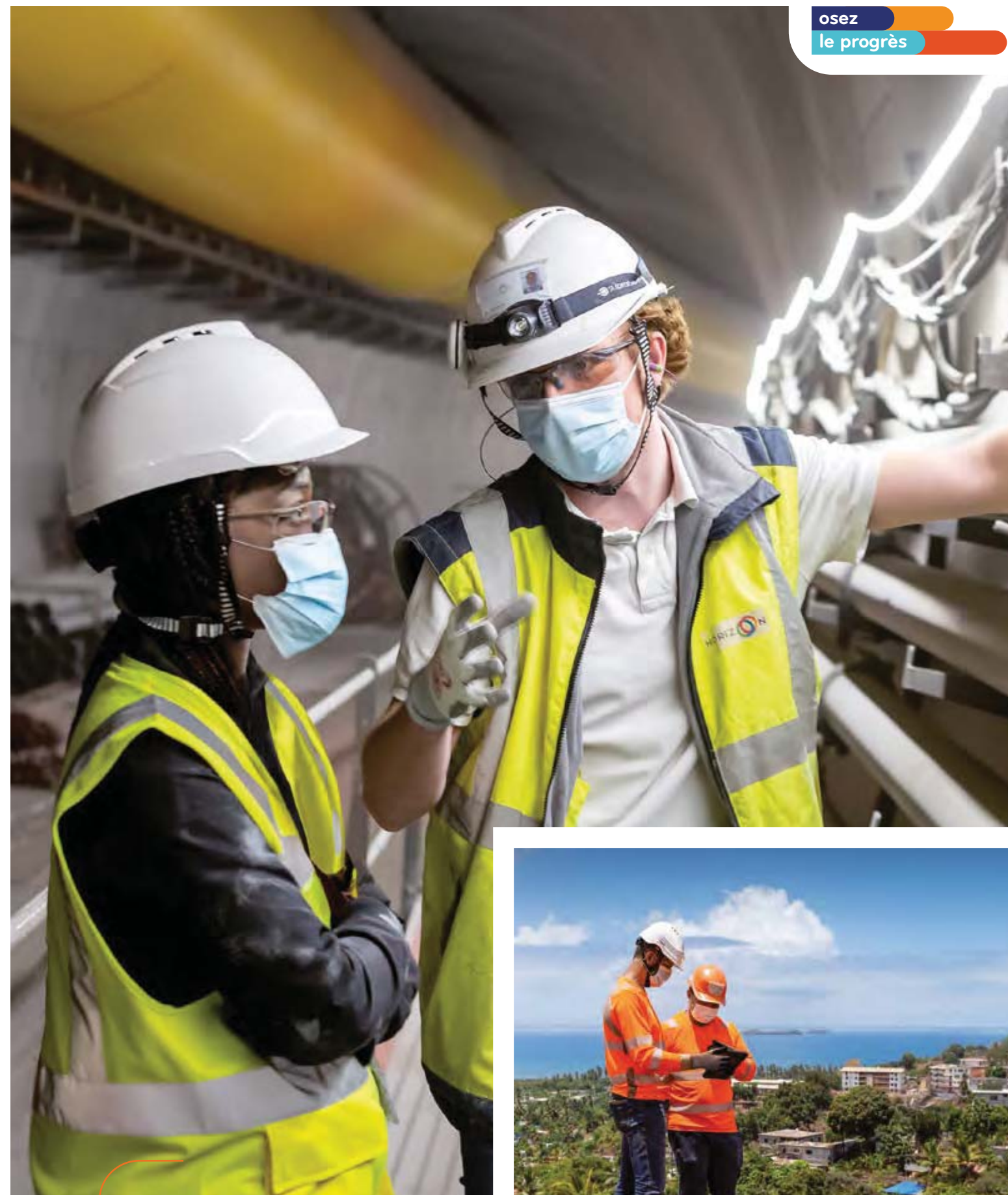
Dans le tunnel de la ligne 15 Sud - lot T3A (Grand Paris Express) qui reliera les gares Pont de Sèvres et Fort d'Issy-Vanves-Clamart
