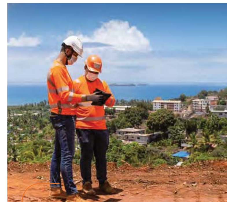
Sur les hauteurs de Mayotte, Colas participe à la construction du futur technopôle de Dembéné.
