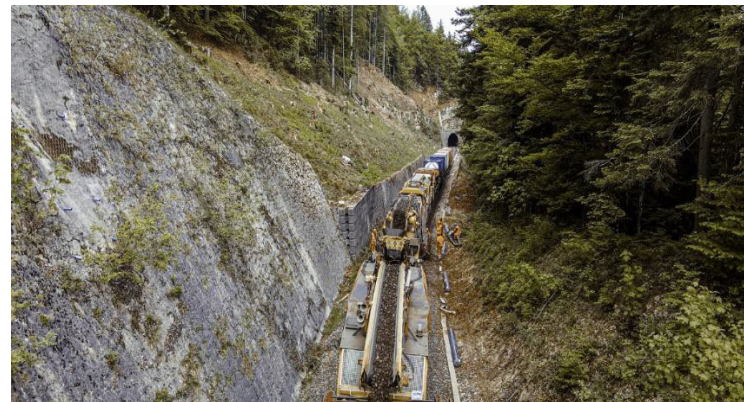
Renouvellement de voie de la ligne des Horlogers dans le Doubs - France
