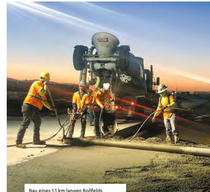
Bau eines 1,1 km langen Rollfelds am internationalen Flughafen von Los Angeles.
