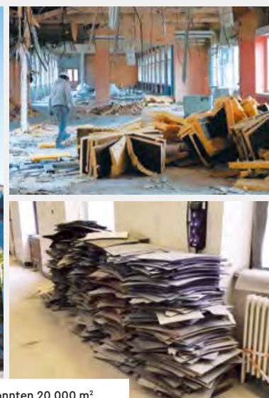
Bei der Renovierung des Hôtel des Postes in Straßburg konnten 20 000 m 2 der bestehenden Baustrukturen beibehalten werden, 1 000 Holzfensterrahmen wurden wiederverwendet und 2 700 m 2 Teppichboden wurde recycelt.
