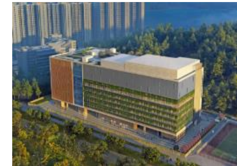
Centre de services des autorités de santé Hong Kong (202 M€) Bouygues Construction
