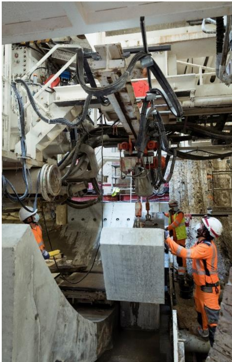
Gare de Vitry-sur-Seine sur la future ligne 15 Sud du Grand Paris - France
