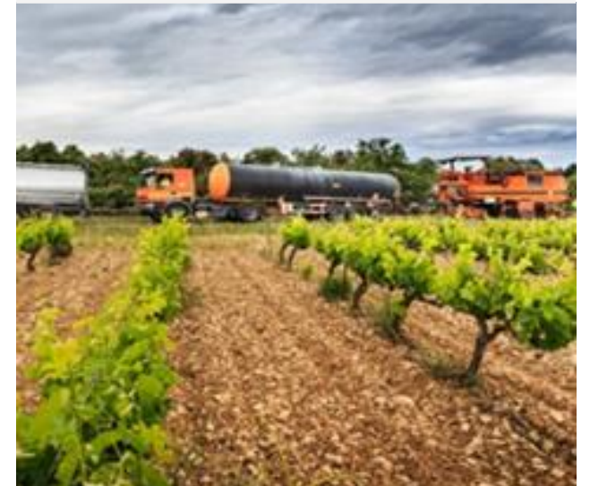
Un chantier Colas de recyclage en place
