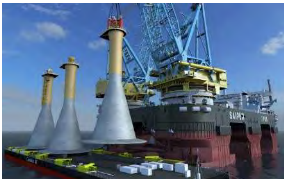
Réalisation des travaux de conception, de construction et d'installation des 71 embases du futur parc éolien en mer de Fécamp – France (552 M€) a
