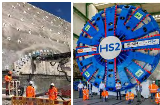
Tronçon C1 – Ligne à grande vitesse HS2 – Royaume-Uni (1,1 Md€) b
