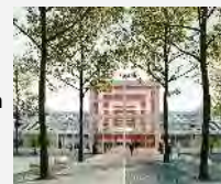
Collège Anne Frank d'Antony Projet de réhabilitation et rénovation énergétique
