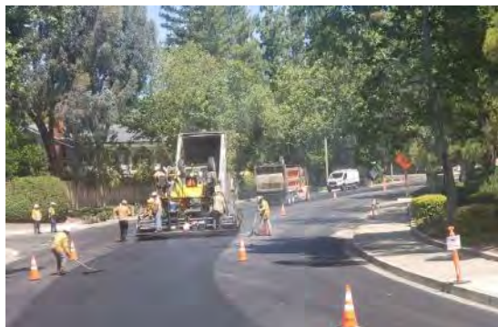
160 M€ de contrats aux Etats-Unis, dont un contrat de 58 M€ pour la réfection de 2 sections de l'Interstate 80 en Pennsylvanie
