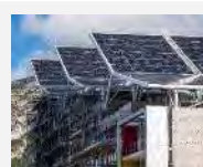
ABC Premier concept de bâtiment « autonome » de France, livré à Grenoble
