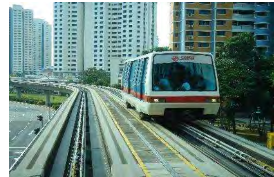
Remplacement de l'alimentation électrique d'une ligne de métro léger (LRT) – Singapour (41 M€)
