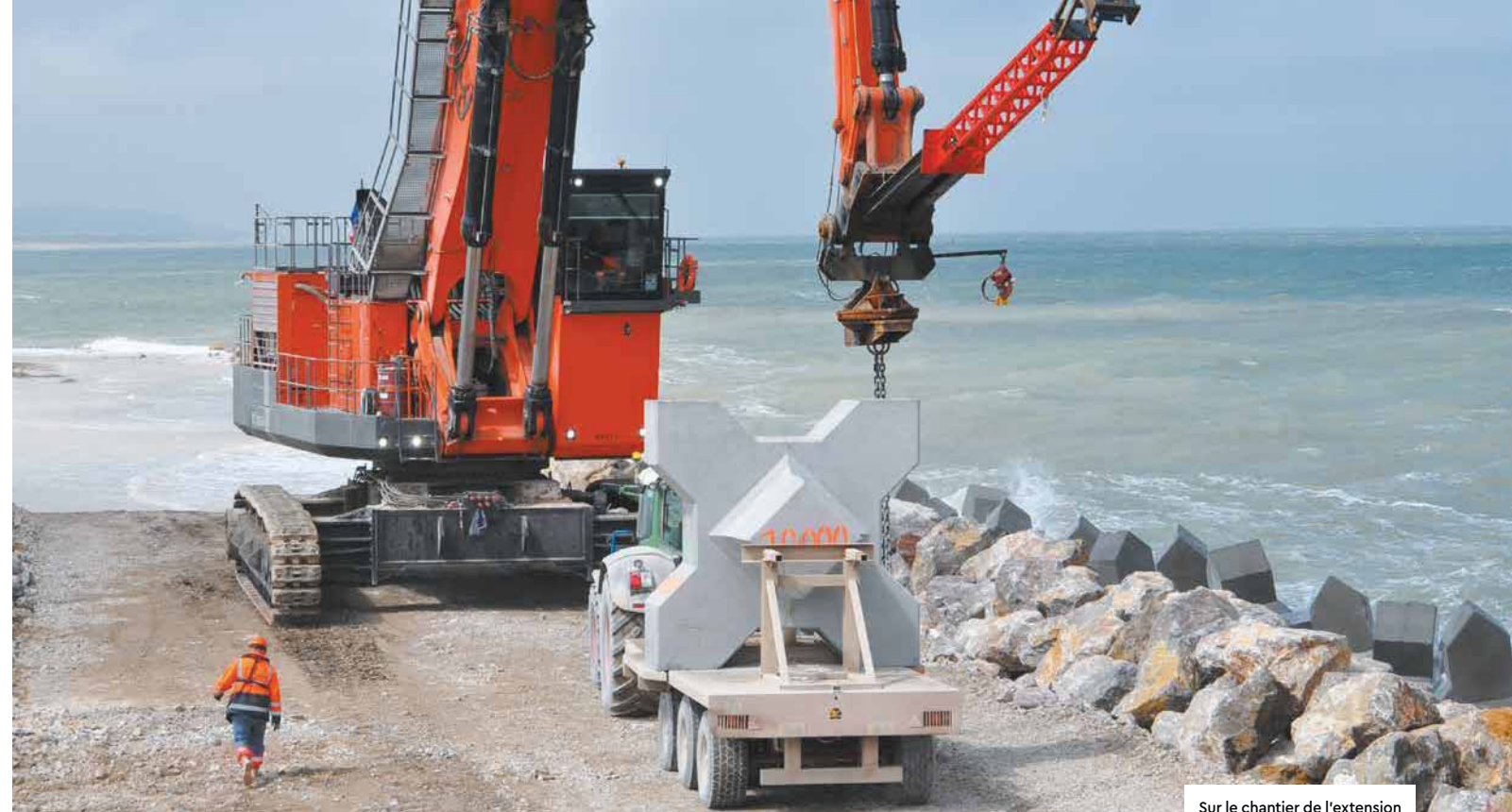
Sur le chantier de l'extension du port de Calais
