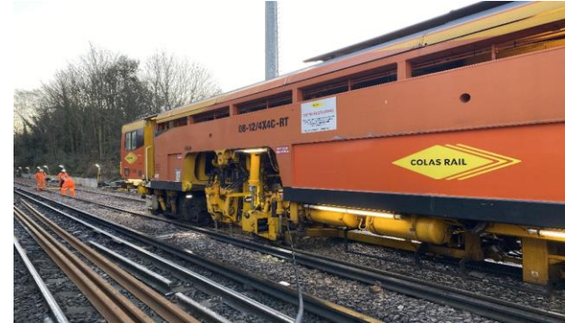
Travaux sur voies ferroviaires pour Network Rail - Royaume-Uni
