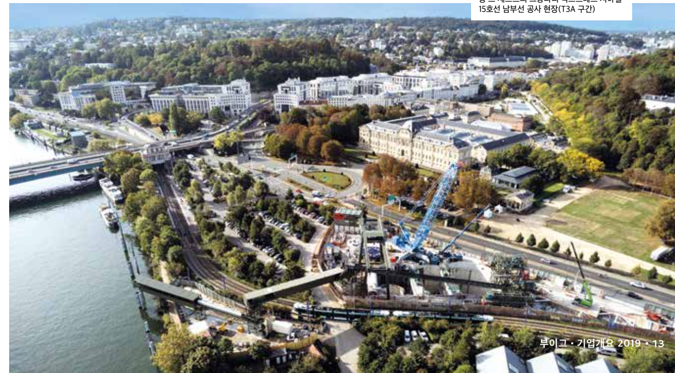
퐁 드 세브르의 그랑파리 익스프레스 지하철 15호선 남부선 공사 현장(T3A 구간)
