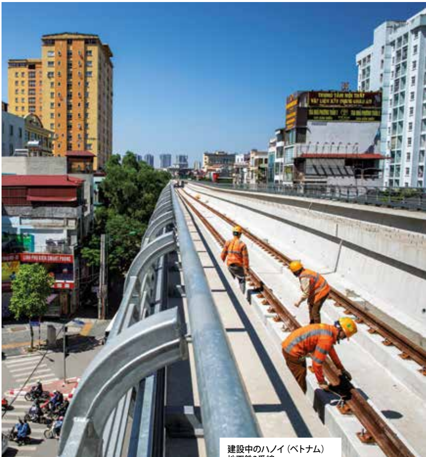
建設中のハノイ（ベトナム）地下鉄3番線
