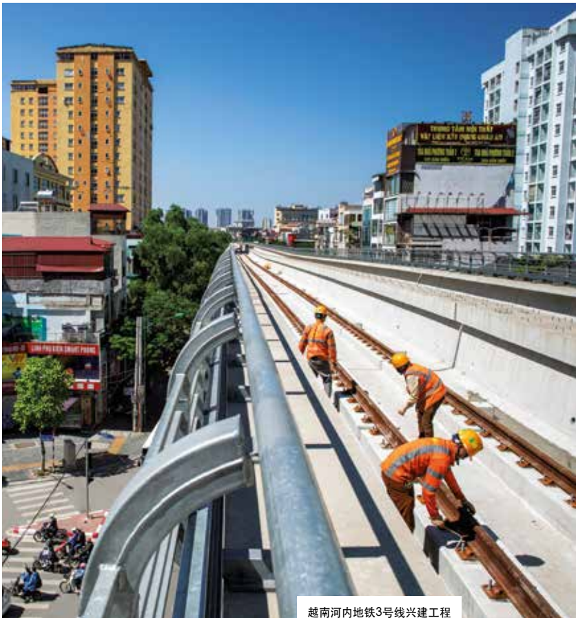
越南河内地铁3号线兴建工程
