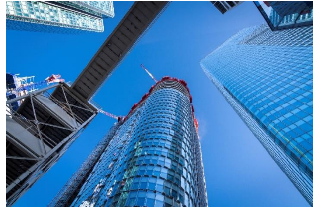
Work on Tour Alto – Paris-La Défense – France
