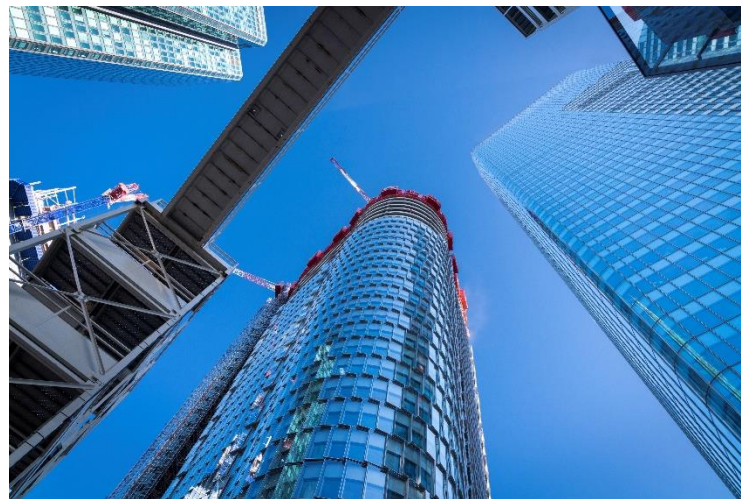
Chantier de la Tour Alto – Paris La Défense
