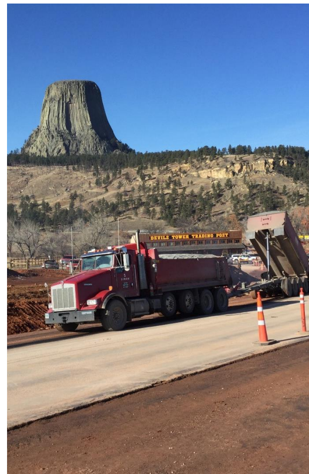
Travaux routiers dans le Wyoming à Devils Tower – États-Unis
