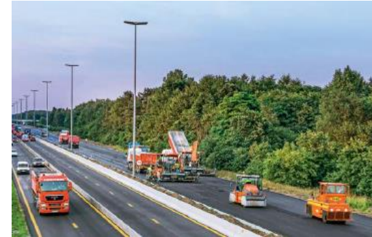
Réhabilitation de 9 km de l'E34 : 100% des matériaux de l'ancienne infrastructure ont été recyclés dans la nouvelle chaussée
