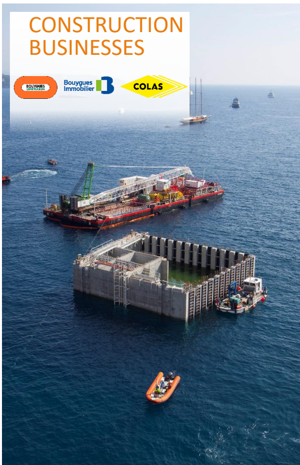
Anse du Portier offshore extension – Monaco
