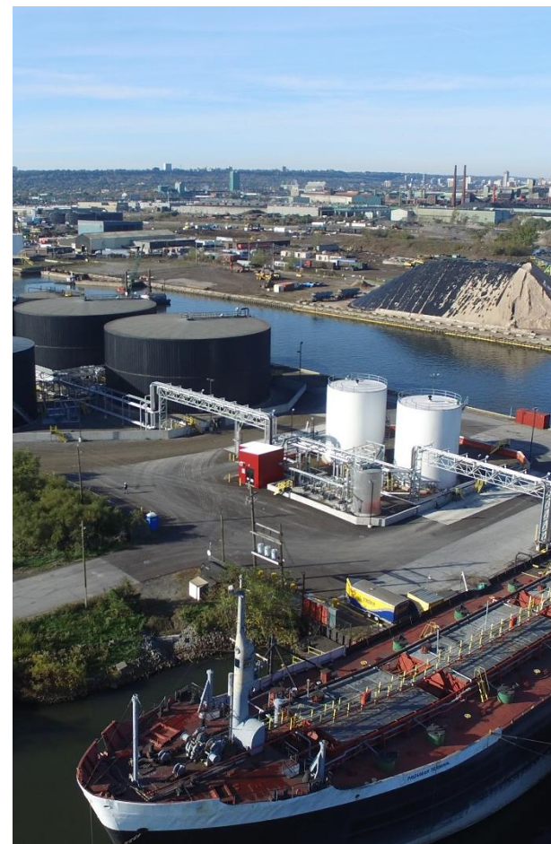
Infrastructures de Miller McAsphalt – Canada
