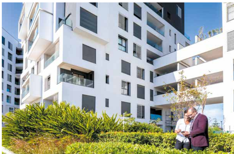
À Casablanca, Les Faubourgs d'Anfa sont labellisés HQE TM grâce à la production d'énergies renouvelables notamment.
