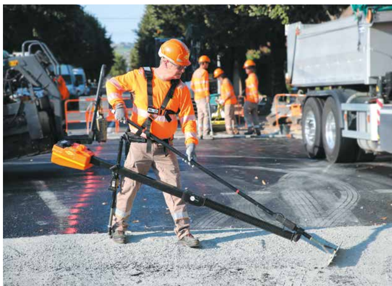
Présenté à Vivatech 2018, l'exosquelette "ExoPush" réduit l'effort de mise en œuvre manuelle des enrobés tout en améliorant les conditions de travail.
