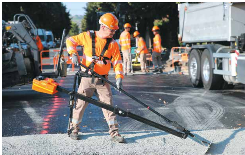
舗装材の施設作業を軽減する装置「エグゾブッシュ」 (最新技術の展示会「ビバテック 2018」で紹介)
