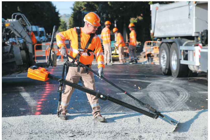
비바테크 2018에 출품된 외골격 장치 <엑소푸쉬>는 코팅제 설치의 노동강도를 줄여 주는 동시에, 근무조건을 개선해 준다.
