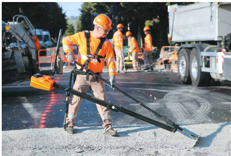
于2018年 Vivatech 展中亮相的外骨骼式机械手臂“ExoPush”能减少铺覆沥青混合料时的体力消耗，有效改善工作状况。
