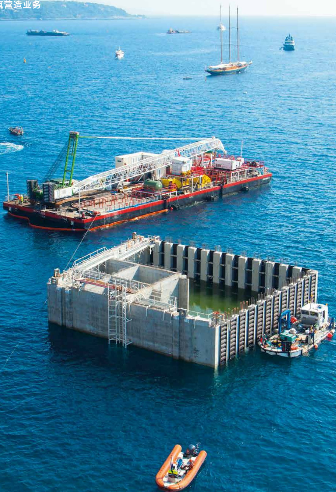
布依格建筑在摩纳哥进行的填海造陆工程所需18个沉箱于马赛大港预制。
