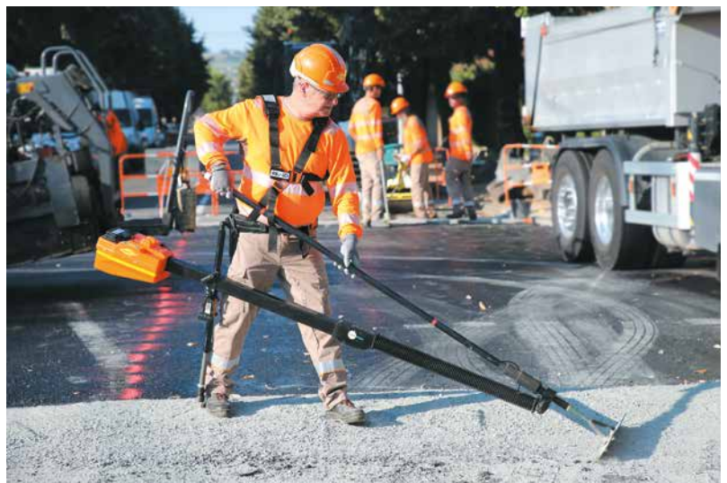
Das auf der Viva Technology 2018 präsentierte Exoskelett „ExoPush“ verringert die körperliche Belastung beim manuellen Einbau von Mischgut und optimiert gleichzeitig die Arbeitsbedingungen.
