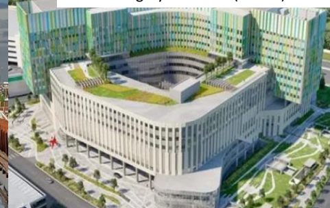
Lot électricité et SI d'un centre médical à Calgary – Canada (58 M€)
