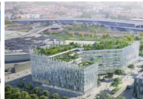
Conception et construction des futurs bureaux de la métropole européenne de Lille (154 M€)
