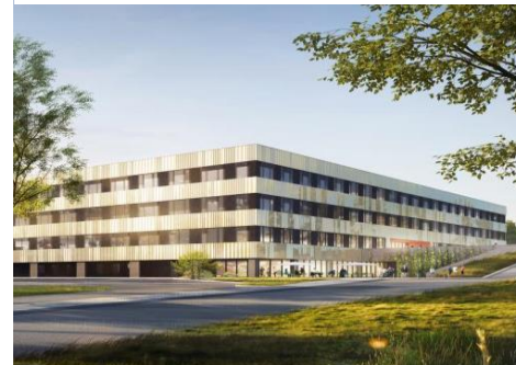
Construction du futur Hôpital de Maubeuge (63 M€)
