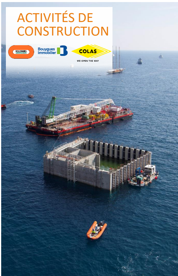
Caisson de l'Anse du portier – Monaco
