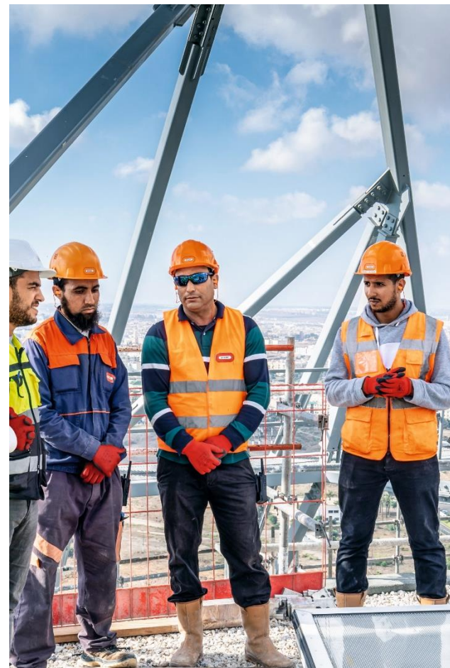
Réunion de chantier à Casablanca
