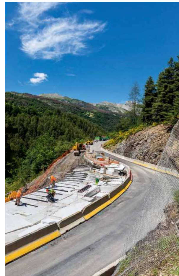
Route départementale 908 au col d'Allos - France
