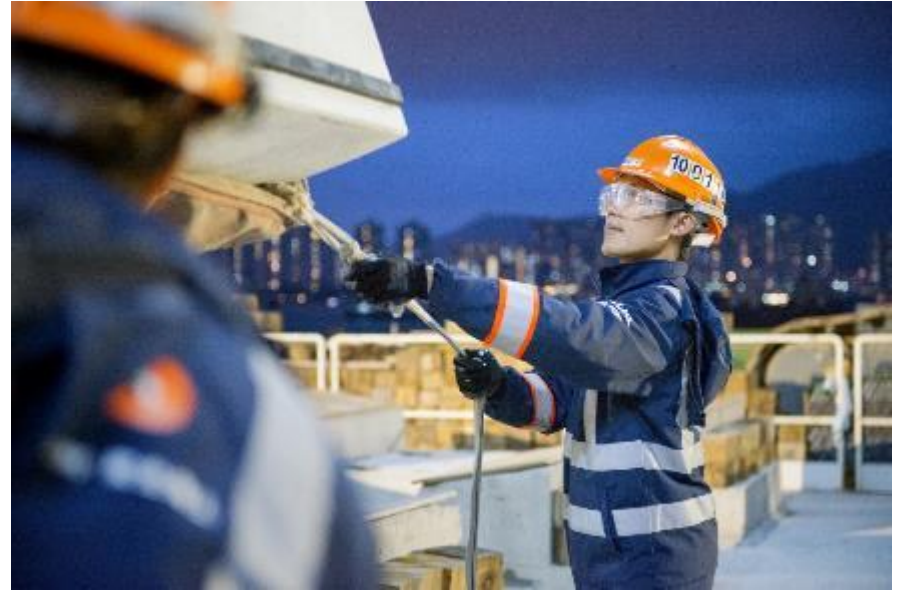
Collaborateur sur un chantier à Hong-Kong
