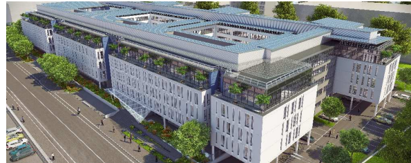
Green Office® Spring à Nanterre - certifié NF HQE exceptionnel
