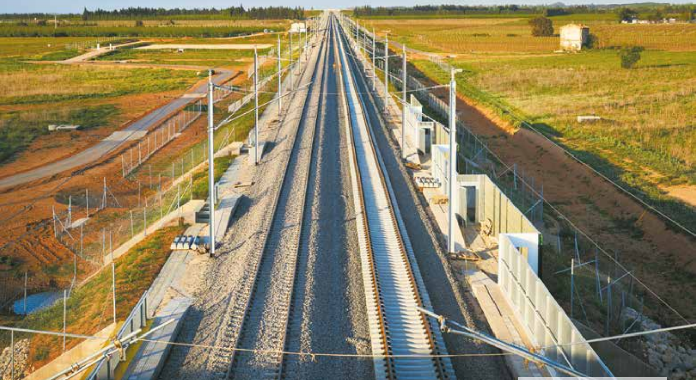
于欧博尔 (Aubord) 铺设铁轨, 这是法国尼姆和蒙佩里耶铁路绕行工程的现场情景。
