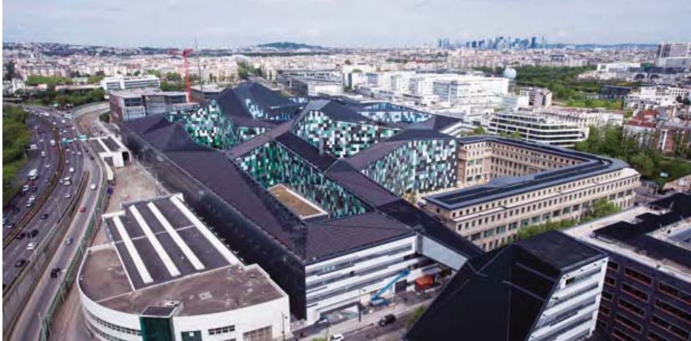
📍 En 2015, Bouygues Construction a livré le ministère de la Défense à Paris.
