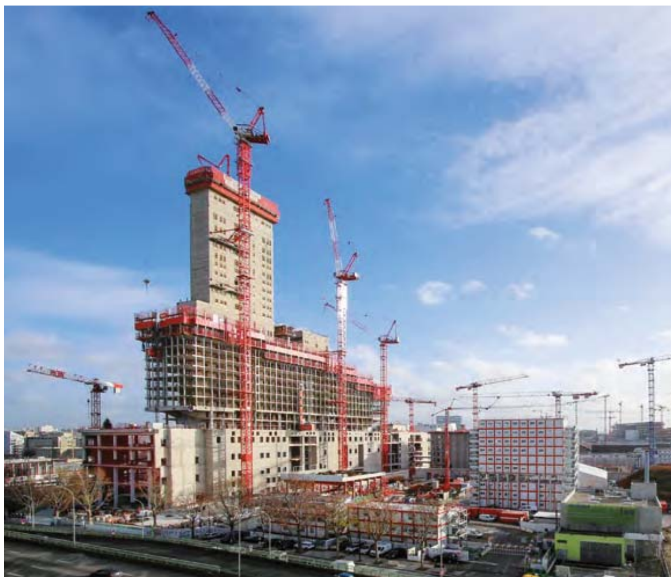
📷 Conçu par l'architecte Renzo Piano, le Palais de Justice en cours de construction à Paris
