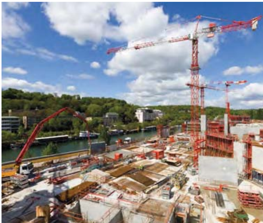
Chantier de la Cité musicale départementale labellisée BiodiverCity
