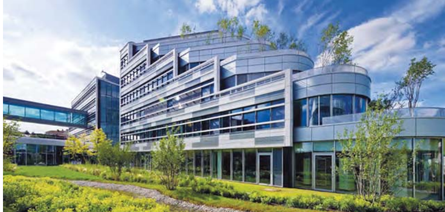
📷 Le Campus Sanofi Val de Bièvre à Gentilly, référence emblématique de la démarche de rénovation Rehagreen® (Bouygues Immobilier)
