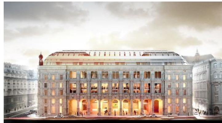
Rénovation de La Poste du Louvre en un bâtiment à usage mixte – Paris, France
