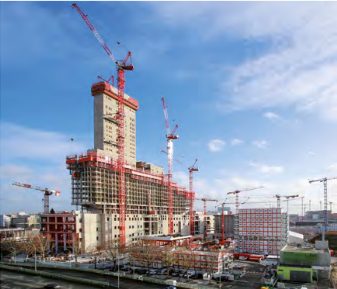
法国司法大楼由建筑师伦佐·皮亚诺 (Renzo Piano) 设计, 目前正在巴黎兴建中。
