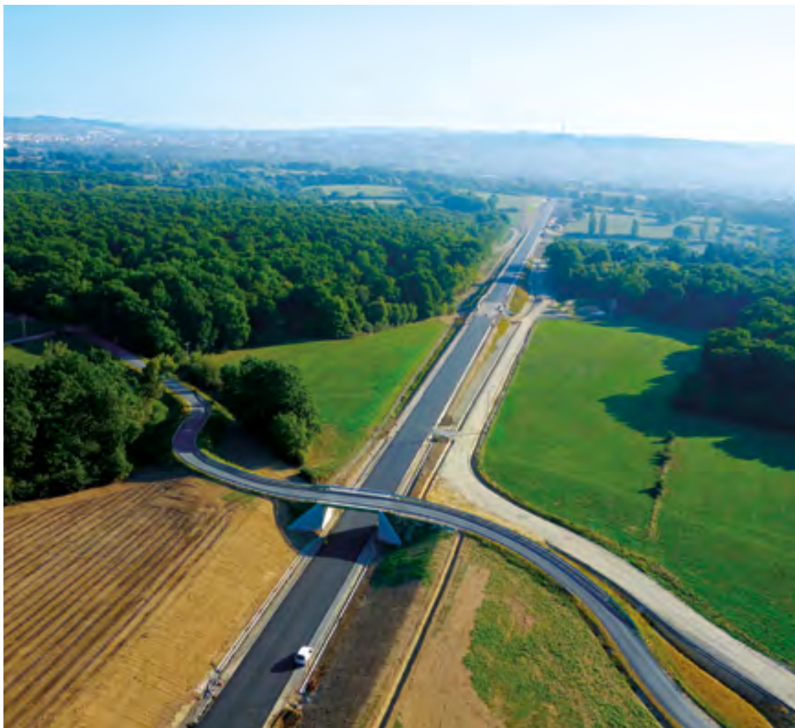
法国维希（Vichy）市西南侧绕城公路是一个公私合营（PPP）建设项目，长 18.6 公里，于 2016 年 1 月完工交付。
