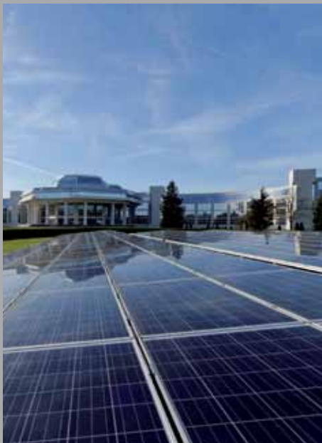
布依格建筑（Bouygues Construction）公司总部 Challenger，环境改建中
