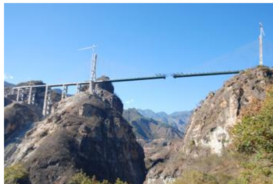
Pont de Baluarte, Mexique
