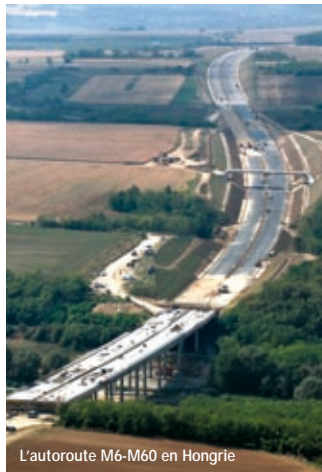
L'autoroute M6-M60 en Hongrie
