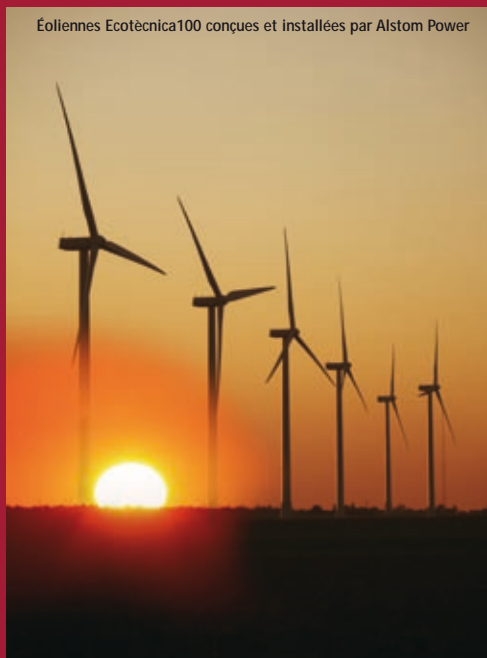
Éoliennes Ecotecnica100 conçues et installées par Alstom Power
