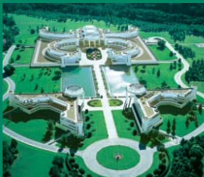
Challenger, siège social de Bouygues Construction
