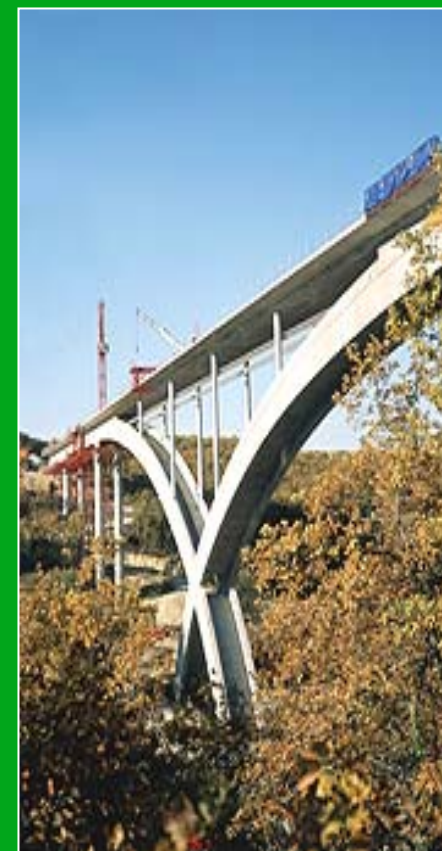
Languienne viaduct (Charente, France)
