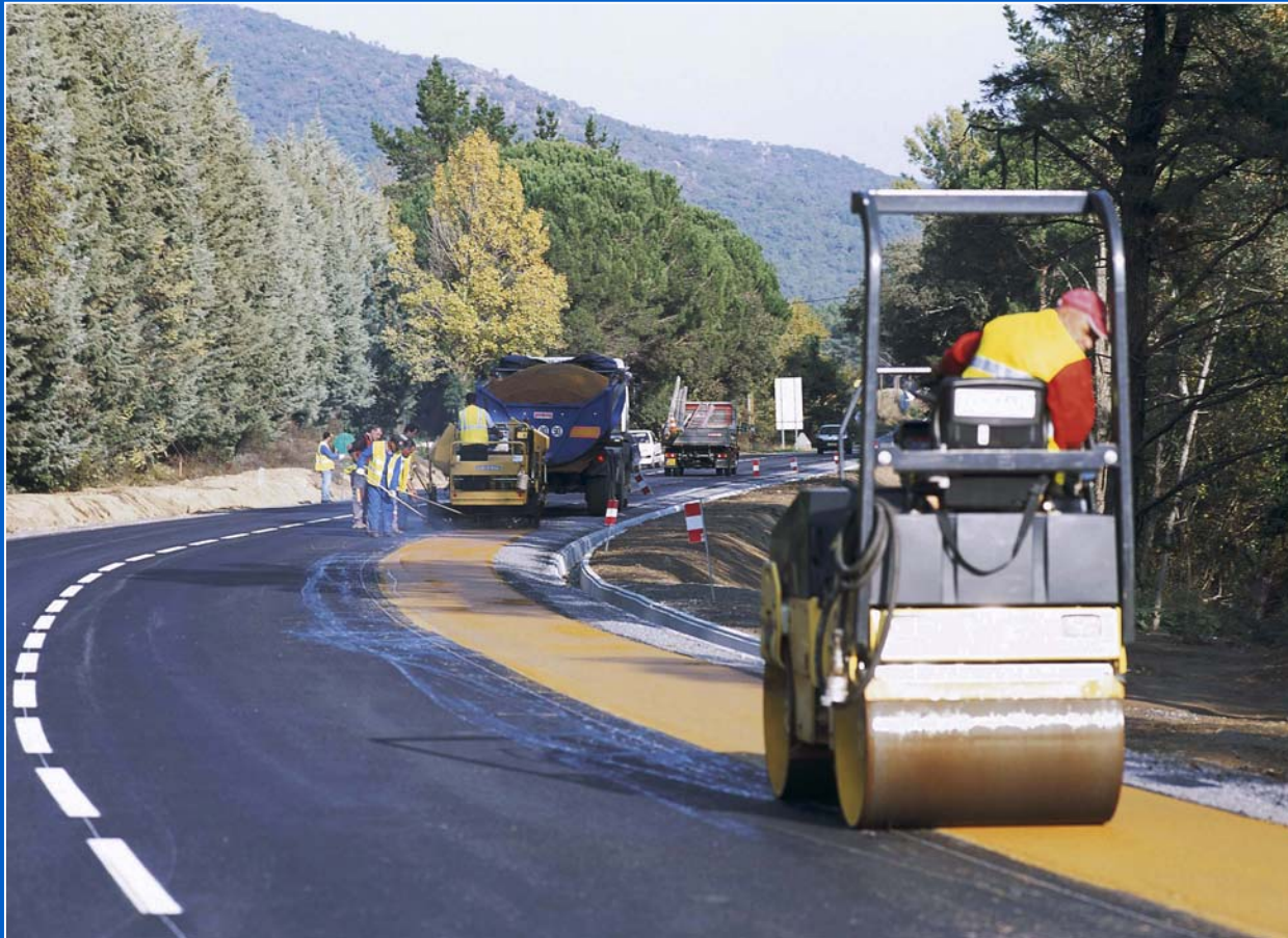
Rénovation de route (France)
