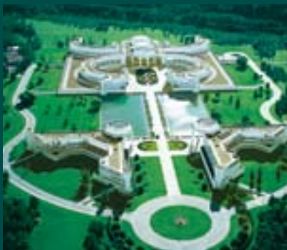
Challenger, siège social de Bouygues Construction
