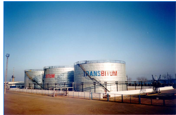
Dépôt Transbitum Port de Mangalia, Roumanie
