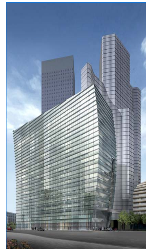
Immeuble Exaltis, Paris La Défense
