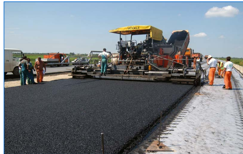
Mise en oeuvre d'enrobés, Hongrie
