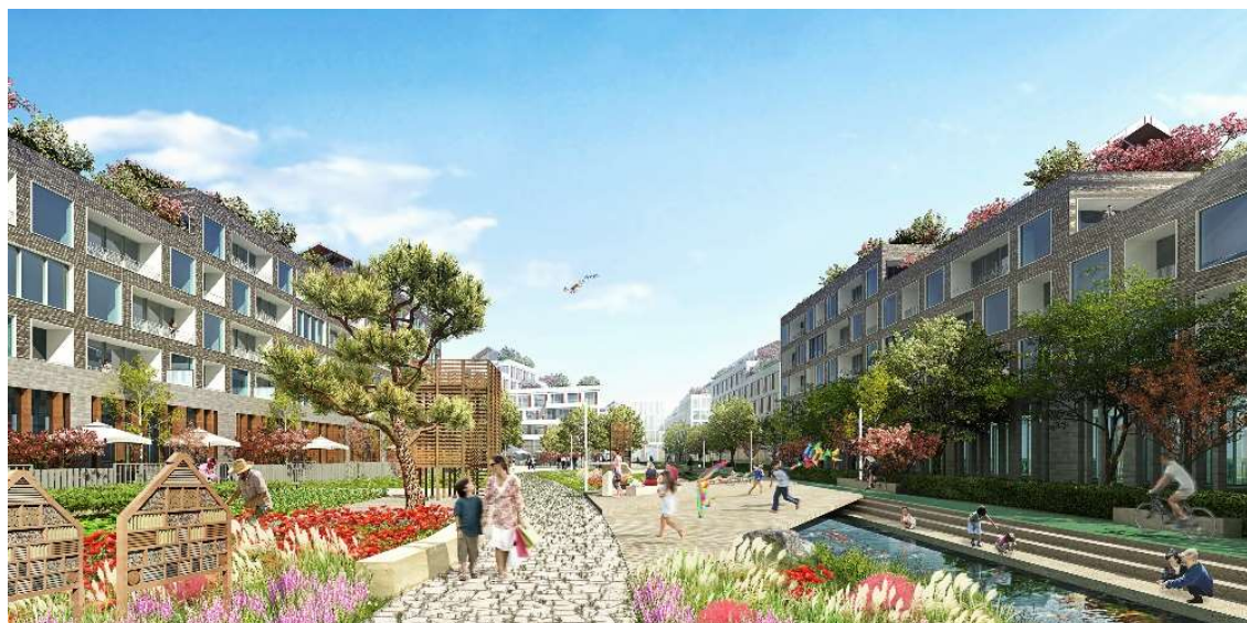
Crédits : Agence d'architectes et urbanistes : AREP – Paysagiste : In Situ – Bureau d'étude : INGEROP.
